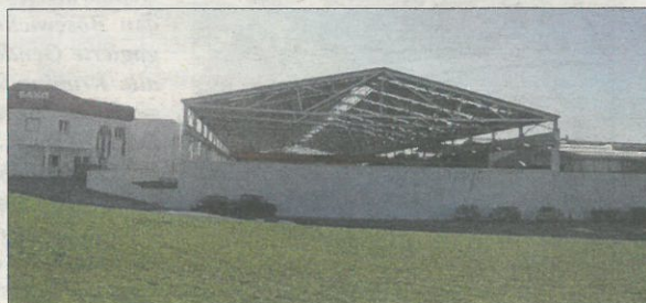
Gewaltige Produktionshalle der Firma SAKO in Ratschendorf.
